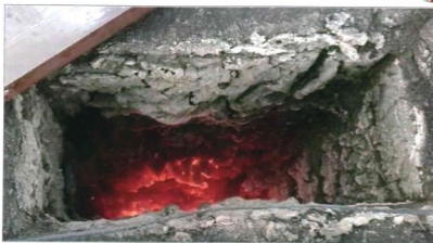
↑..... Wnętrze przewodu kominowego
